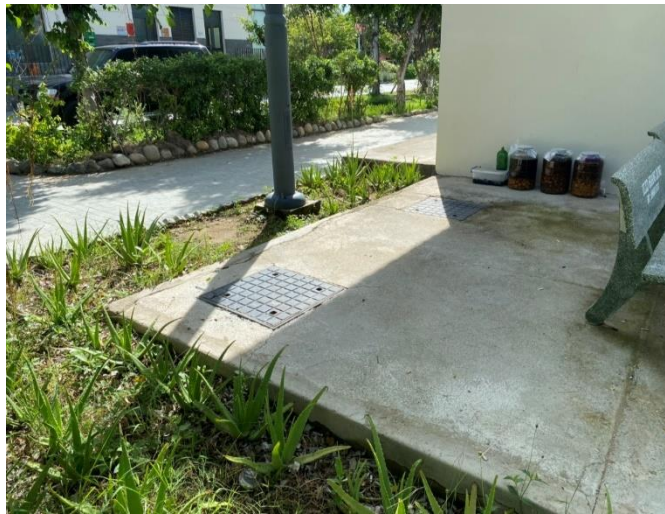
Hình 3.4 Các hố ga thoát nước thải
